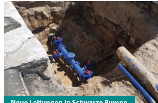
Neue Leitungen in Schwarze Pumpe
